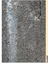
Fissuration consécutive à la corrosion des armatures.
