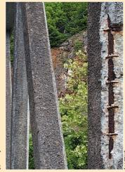
Epaufrure laissant apparaître les armatures corrodées.
