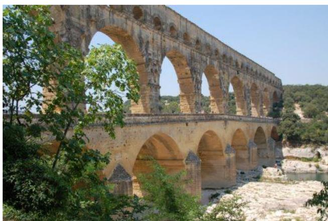
***Pont du Gard** (1er siècle apr. J.-C.) : Utilisation de mortier hydraulique en produit d'étanchéité de la canalisation où passait l'eau (specus).*
