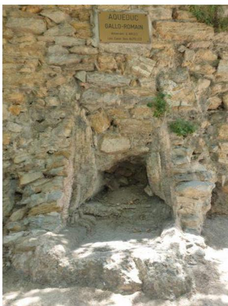
***Vestige de l'aqueduc Gallo-Romain reliant Arles aux Alpilles**, enduit intérieurement d'une couche de mortier pour en assurer l'étanchéité*
