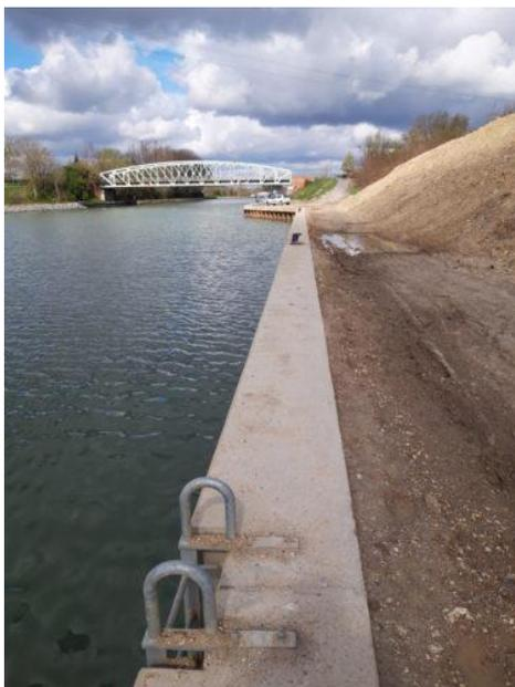
*Poutre de couronnement, Chantier de réfection de berge de Goelzin, 2018 © VNF*
