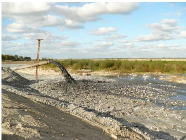
*Rejet de sédiment dragué hydrauliquement avant lagunage © F. LEVEQUE, setec in vivo*
