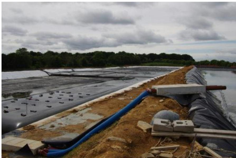
*Déshydratation de sédiments dragués hydrauliquement par boudins géotextiles © F. LEVEQUE, setec in vivo*
