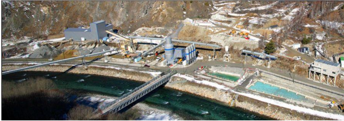
Station de traitement de matériaux de Villarodin-Bourget/Modane - © LTF
