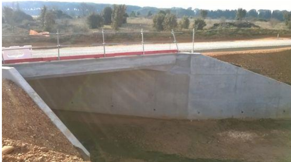
Vue de l'ouvrage
