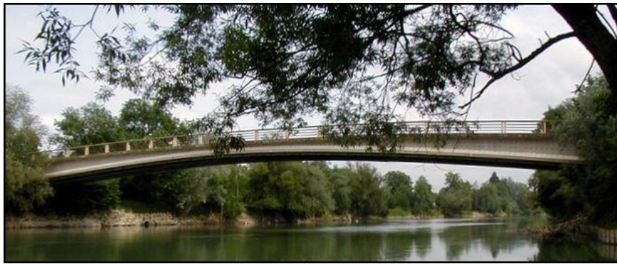
E. Freyssinet, pont d'Esbly, sur la Marne, 1947
