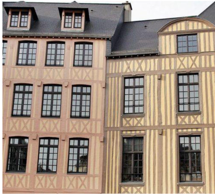
Torchis sur bois longs et courts à Rouen, 17e et 18e siècles
