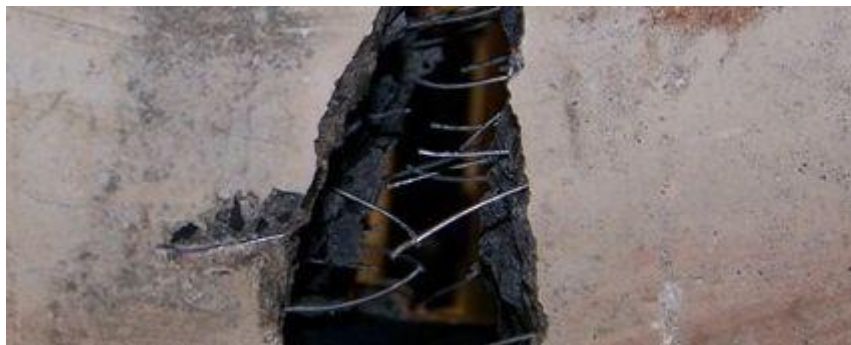
Béton de fibres métalliques
