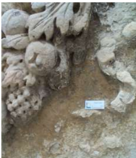
Altération de surface
