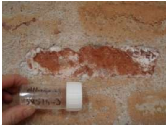
Brique altérée par les sels
