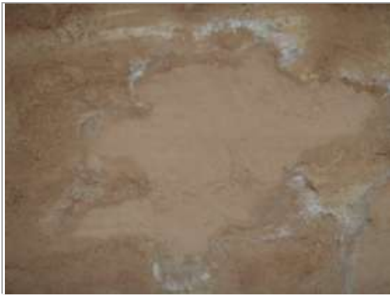
Affleurement de la couleur de la couche intermédiaire de l'enduit
