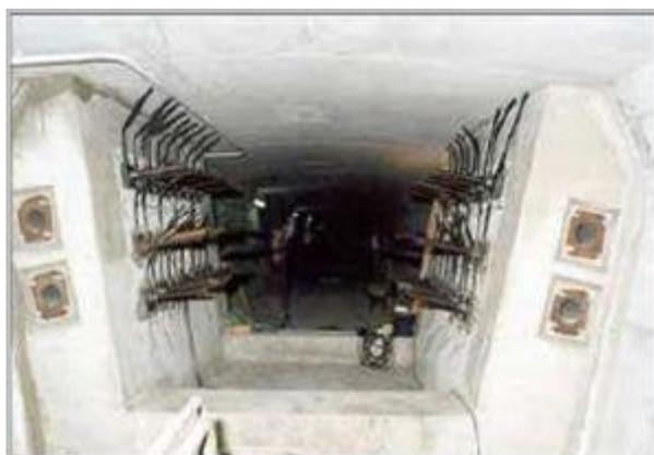
Massif d'ancrage avec barres de précontrainte et plaques d'ancrages
