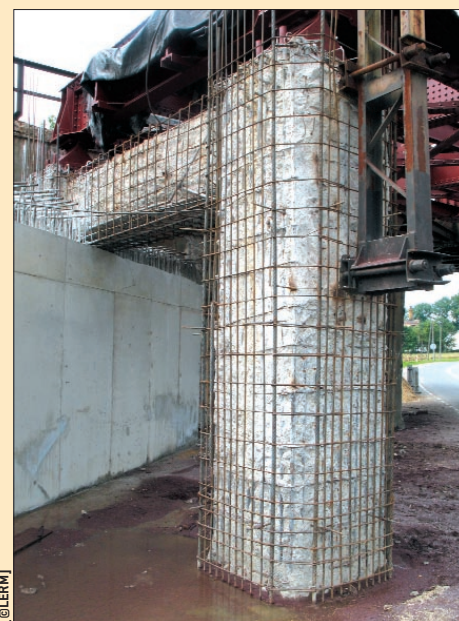
La réparation d'un ouvrage très corrodé peut nécessiter un recalcul de sa structure et éventuellement un renforcement général.
